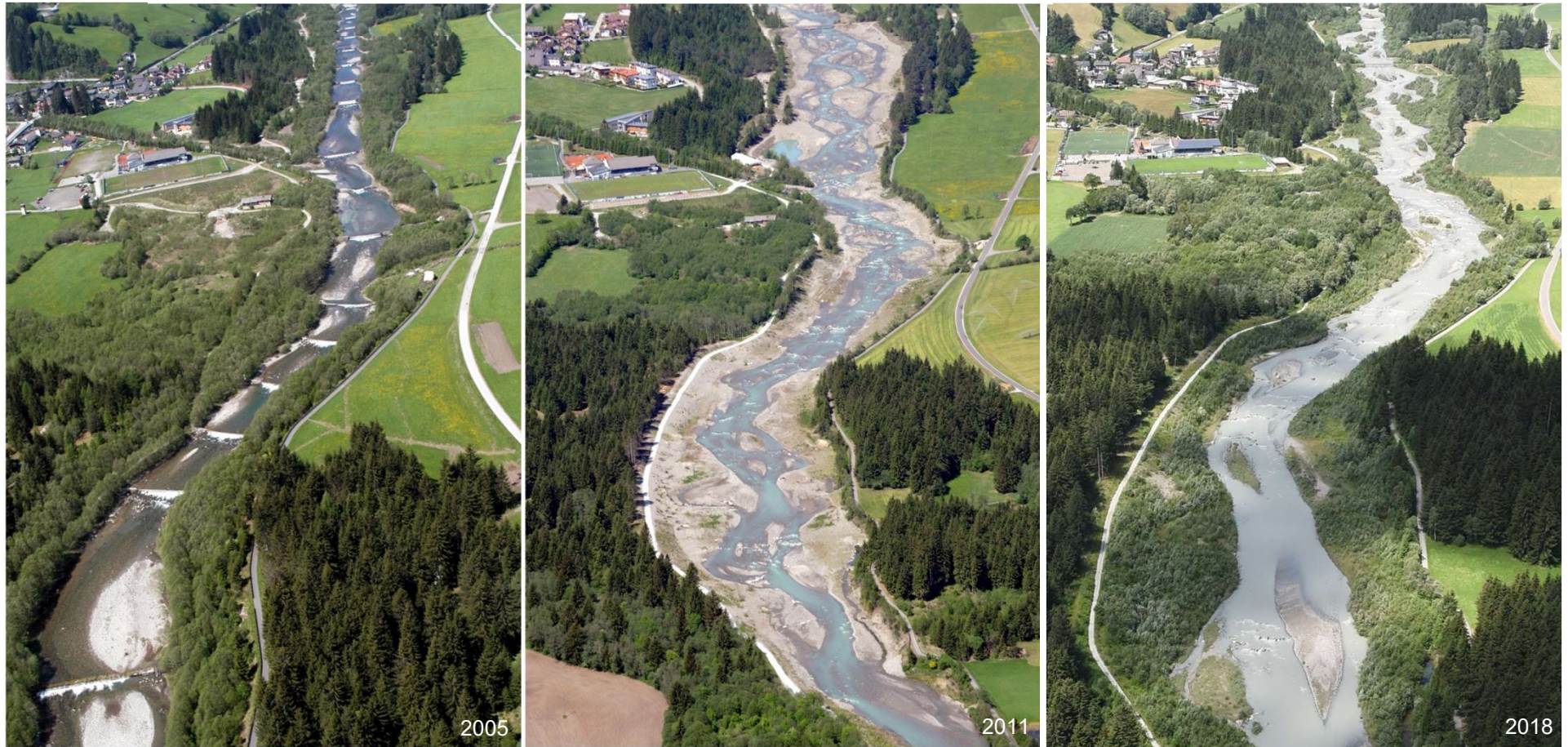
Prima dei lavori
