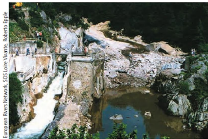
La démolition du barrage de Saint-Étienne-du-Vigan à la dynamite en juin 1998. Le cours d'eau est détourné en rive droite.
